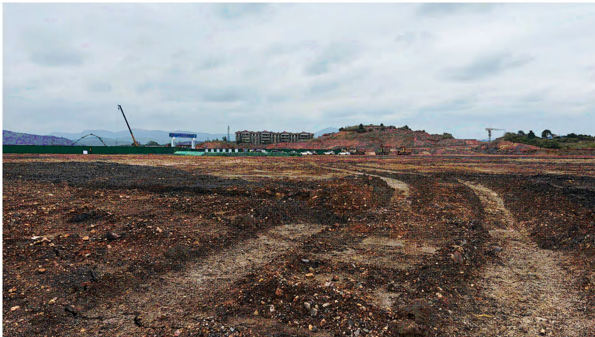
TR01调入地块现场照片
