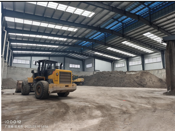
尾砂成品储存车间
