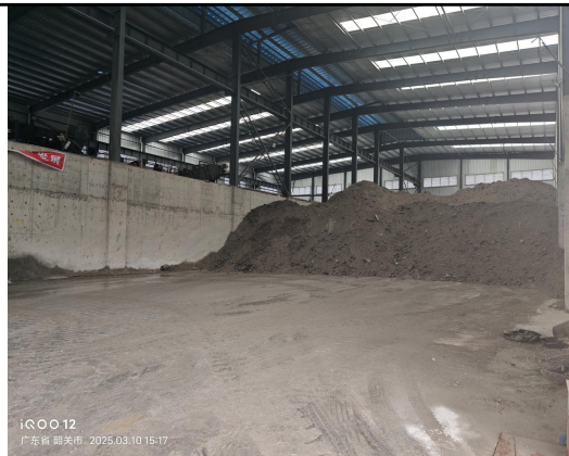
炉渣原料储存车间
