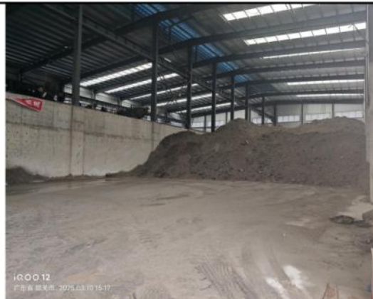
炉渣原料储存车间
