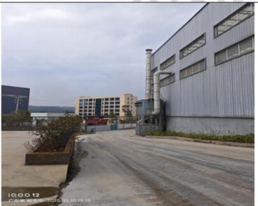
炉渣处理车间废气排气筒 DA001
