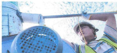
环保制砖车间工艺废气排放口(DA002)
