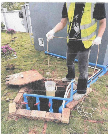
生活污水采样口
