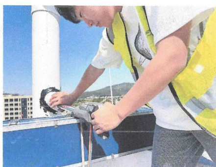
厨房油烟排放口(DA003)
