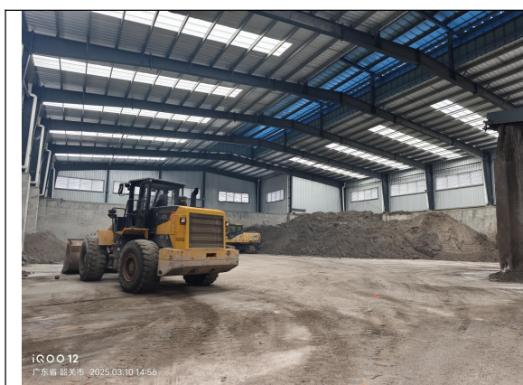
尾砂成品储存车间
