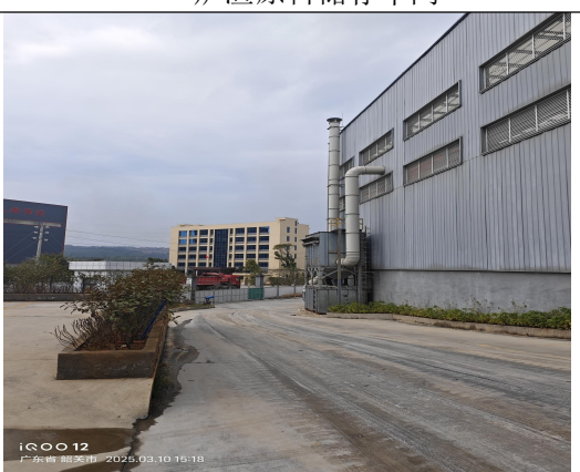
炉渣处理车间废气排气筒 DA001
